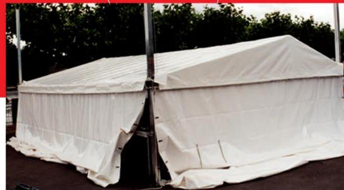
Nach Montage der Stützen- und Dachkonstruktion sowie Befestigen der Planen für Dach und Seiten wird die Dachkonstruktion mittels 4 Handwinden in Position gebracht.
